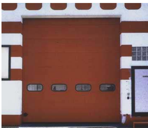
Industrijska sekcijnska vrata sa otvorima i sa pješačkim prolazom
